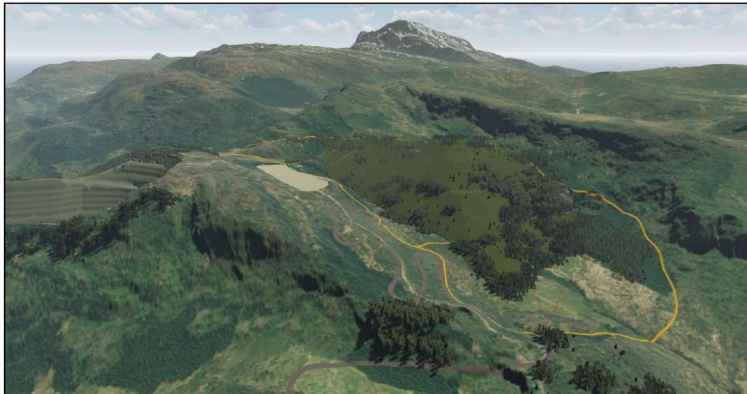
Figur 60 - Figur som viser gråbergsdeponiet etter rehabilitering (retn. SØ-NV)
