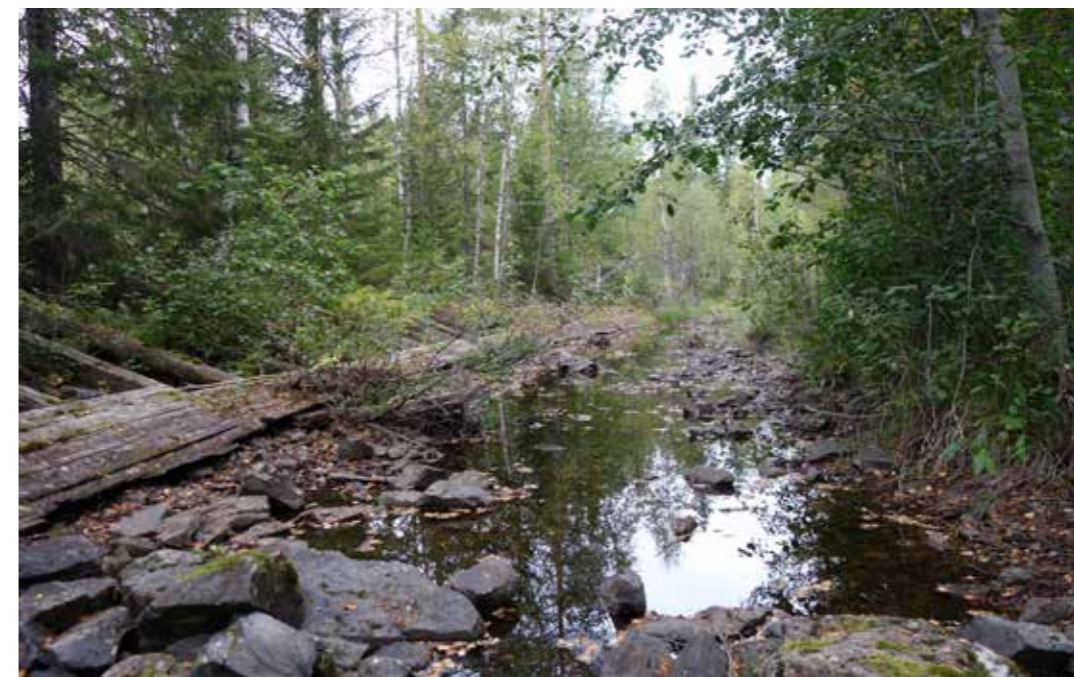
Flåtakanalen. Opparbeidet fløtningskanal for tømmer fra Storflåtan til Vesleflåtan.
