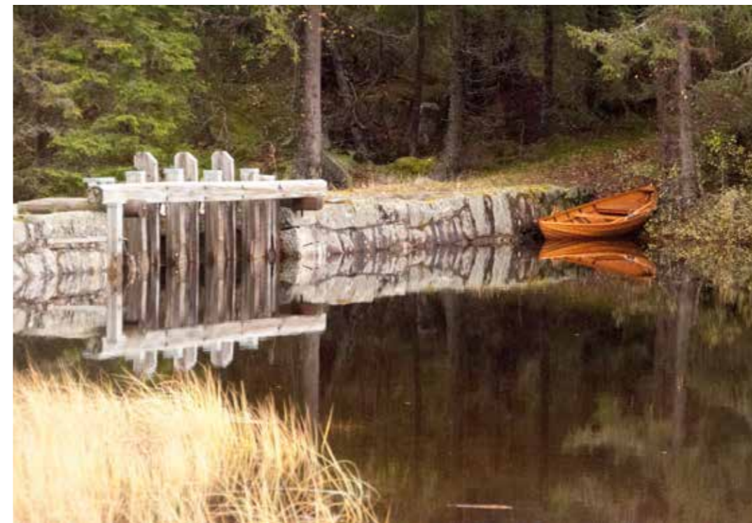
De fleste større vannene i Nordmarka er demmet opp for transport av tømmer vannveien til sagbruket. Her: Spålsdammen. Foto: GA/NOA.
