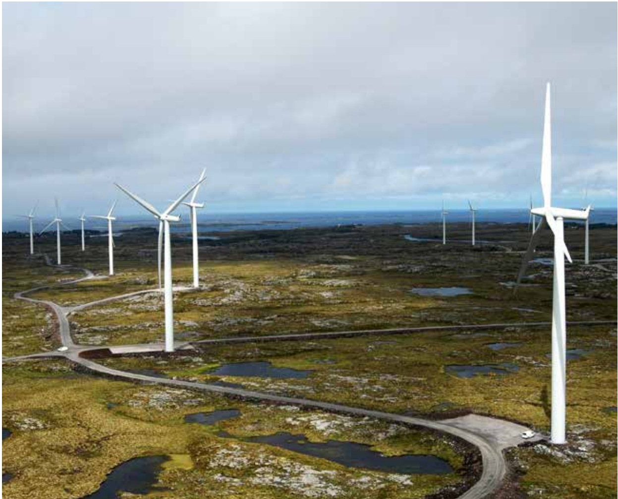
Hittil er minst 50 havørn drept av møllevingene i landets første vindpark på Smøla. Den ble åpnet i 2002 og utvidet i 2005. De 48 nyeste turbinene som er 110 meter høye har bare ca. 20 års levetid og må da skiftes ut med store kostnader. I dag er strømproduksjonen knapt lønnsom, og det er overskudd av strøm i Norge. Foto: Statkraft.
