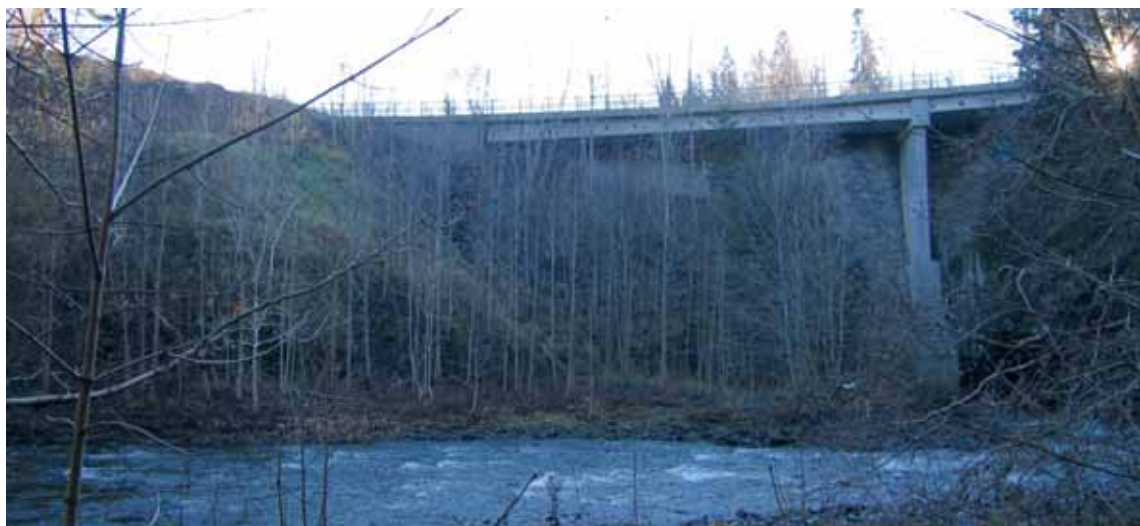
Jarfyllingen sett fra nordsiden. Elvetunnelen er i nederste høyre hjørne og kulverten vil plasseres høyt oppe til venstre.
