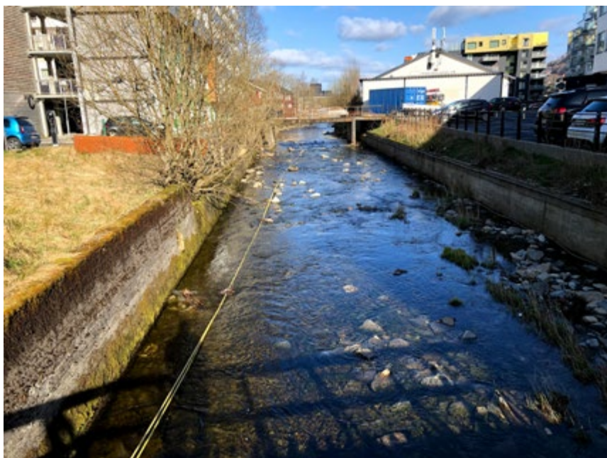
Møllendalselven på vei mot Store Lungegårdsvann. Restaureringen vil innebære at betongkantene fjernes, vannspeilet økes i bredde og det blir en fin elvevegetasjon med stedegne planter. Foto: Harald Simonsen
