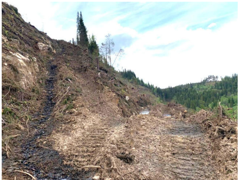
Bilde 1: Driftsvei der skjæring eller fylling avviker mer enn 1m fra opprinnelig bakkenivå over en samlet strekning på mer enn 150 m krever søknad til kommunen. Vegen skal planlegges slik at naturinngrepene blir minst mulig. (Foto: Kjetil Kroksæter)
