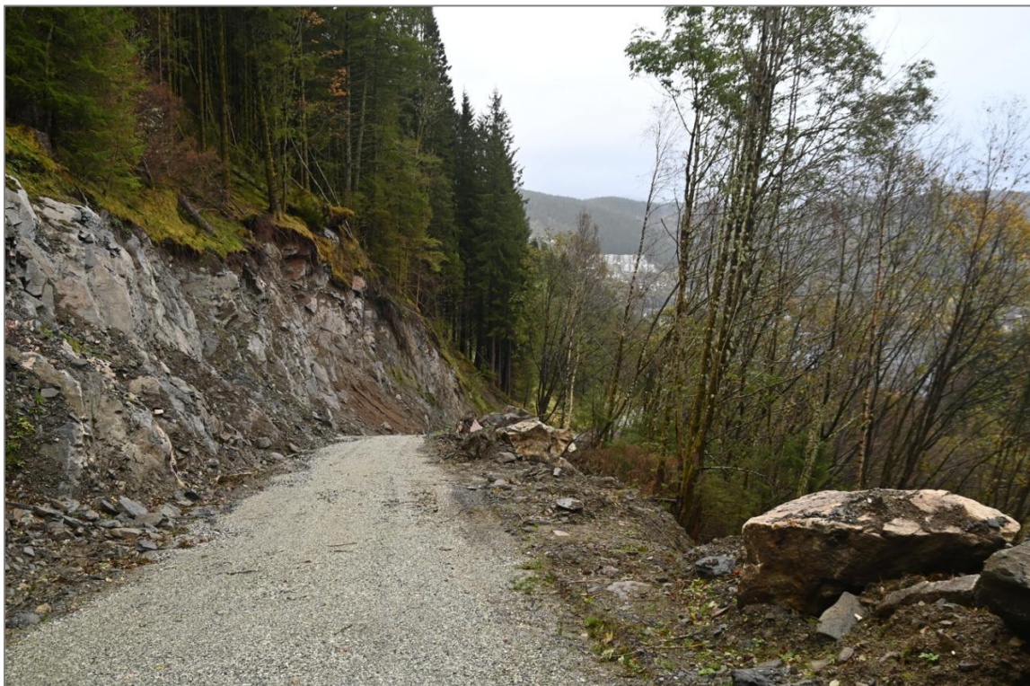
Skjæring på motsatt side av Hamrefjellsvegen.
