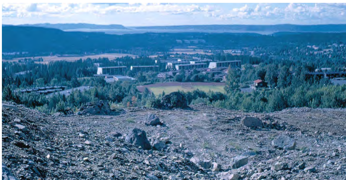
Grustaket i Eineåsen omkring 1972. De store steinene er fjernet og gravearbeidet er påbegynt. Foto: Bjørn Høvik
