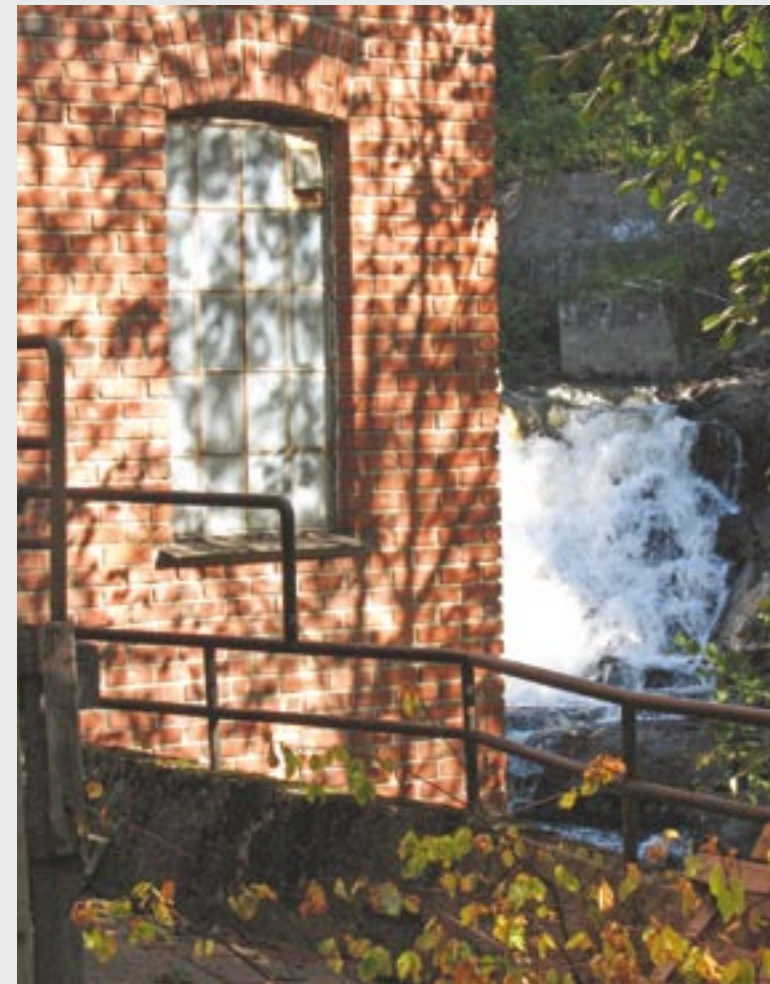
Energi trengs til all virksomhet. Kornmøllen Grini Mølle var i drift fra 1876 til 1904 og nyttet kraften fra fossefallet. I 1914 ble det anlagt en privat kraftstasjon her ved Grini.
