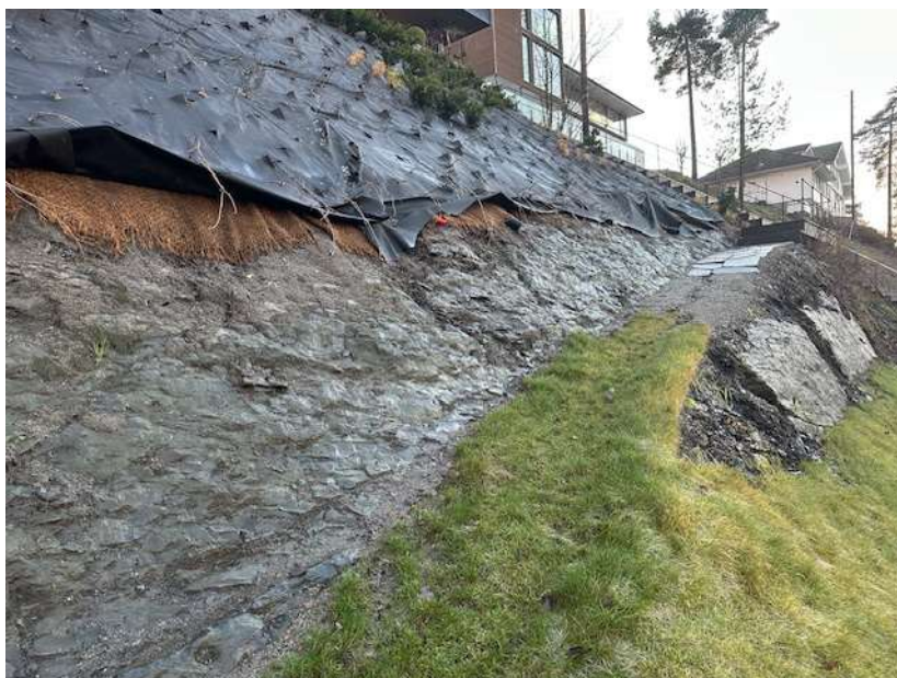
Bilde av skråningen som viser fast fjell – kalkstein, i nedre del av skråningen. Det viser også beplantningen og plenmattene. Foto 17.12.25
