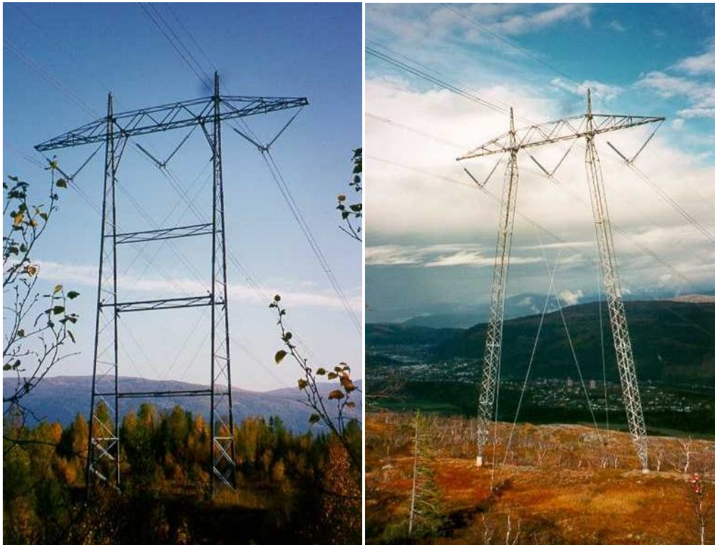
Figur 5: Figuren viser de to mest aktuelle mastetyper for dette prosjektet. Til venstre en selvbærende mast og til høyre en utvendig bardundert mast. Se målsatte skisser i Figur 4.
