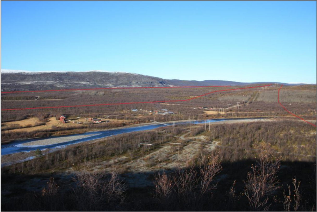
Figur 17: Tre ulike alternativ for kryssing av Stabburselva nordfra sett mot nordvest. Fra venstre Alt 1.1, i midten Alt 1.0, og til høyre Alt 1.7 lengst mot øst. Midt i bildet sees 132 kV-ledningen Skaidi – Lakselv og 66 kV-ledningen Smørfjord – Lakselv.
