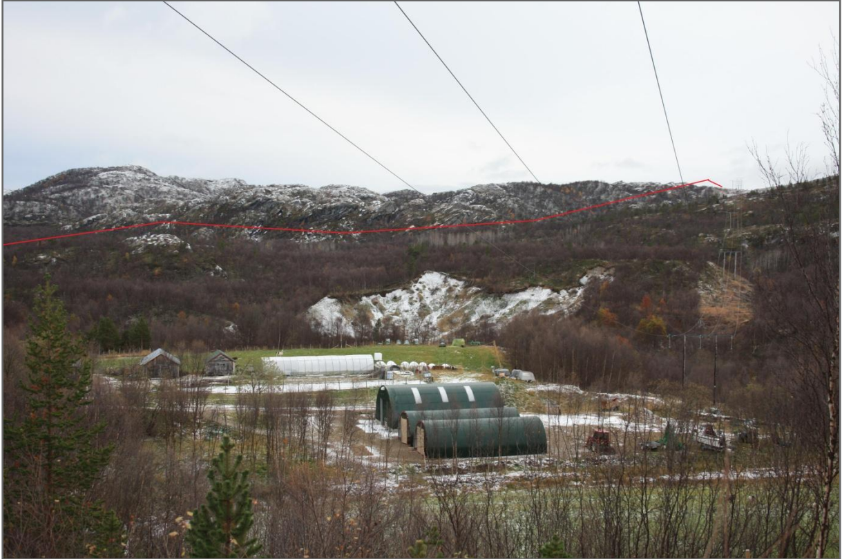
Figur 19: Bildet viser eksisterende 132 kV-ledning Adamselv – Lakselv der den passerer Fossestrand i Lakselv. Statnett anbefaler her å fravike parallellføringen for å unngå nærføring til gården Meldt trasé er vist med rød strek langs foten av åsen bak i bildet.
