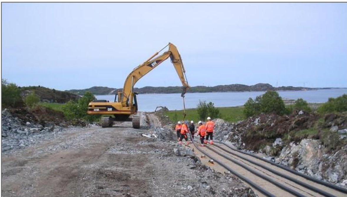
Figur 26: Bildet viser legging av et 420 kV kabelanlegg for vekselstrøm. Her legges det ett kabelsett (tre kabler) + en reservekabel. For å få noenlunde tilsvarende kapasitet på et kabelanlegg som planlagt ny 420 kV-ledning Skaidi-Varangerbotn, må det legges to kabelsett (seks kabler).
