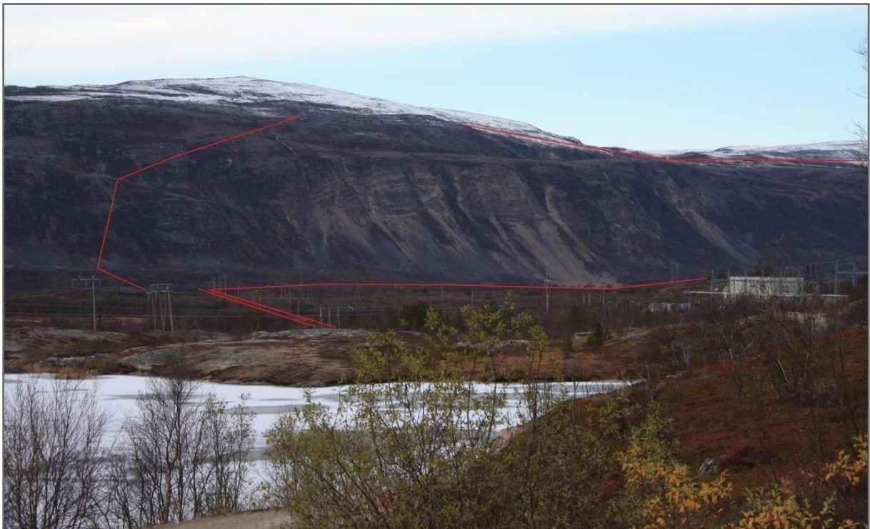
Figur 10: Lakselv transformatorstasjon. Bilder er tatt mot vest på veien opp mot leirstedet Karalaks som ligger ca 800 m øst for stasjonen. Dagens transformatorstasjon sees til høyre i bildet. Planlagt ny stasjon er tenkt lokalisert midt i bildet i nær tilknytning til dagens stasjon. Med rød strek er vist alternative ledningsføringer mot Skaidi. Alternativ 1.2 er lag oppe på fjellet mens alternativ 1.0 ligger parallelt med dagens ledninger i lifoten.
