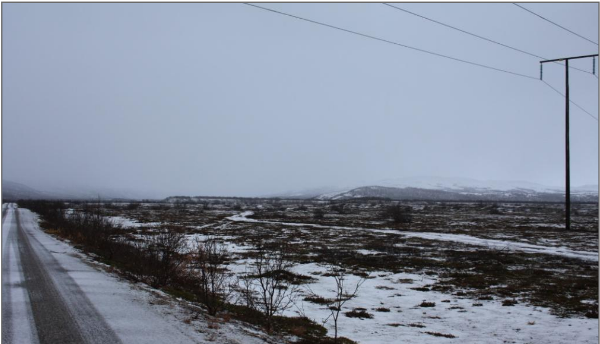
Figur 20: Lebesby transformatorstasjon, alternativ B. Grusmoene i Adamsfjorddalen er vurdert som egnet lokalisering for ny Lebesby transformatorstasjon. Anleggsveien mot Store Måsvatn til venstre. Ledningen i bildet er 132 kV-ledningen Adamselv – Lakselv som er tenkt knyttet til ny stasjon.
