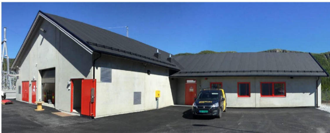
Figur 24: Eksempel på et Statnett standard kontrollhus, her fra Hofstad transformatorstasjon
