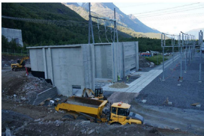
Figur 25: Eksempel på transformatorsjakt i betong
