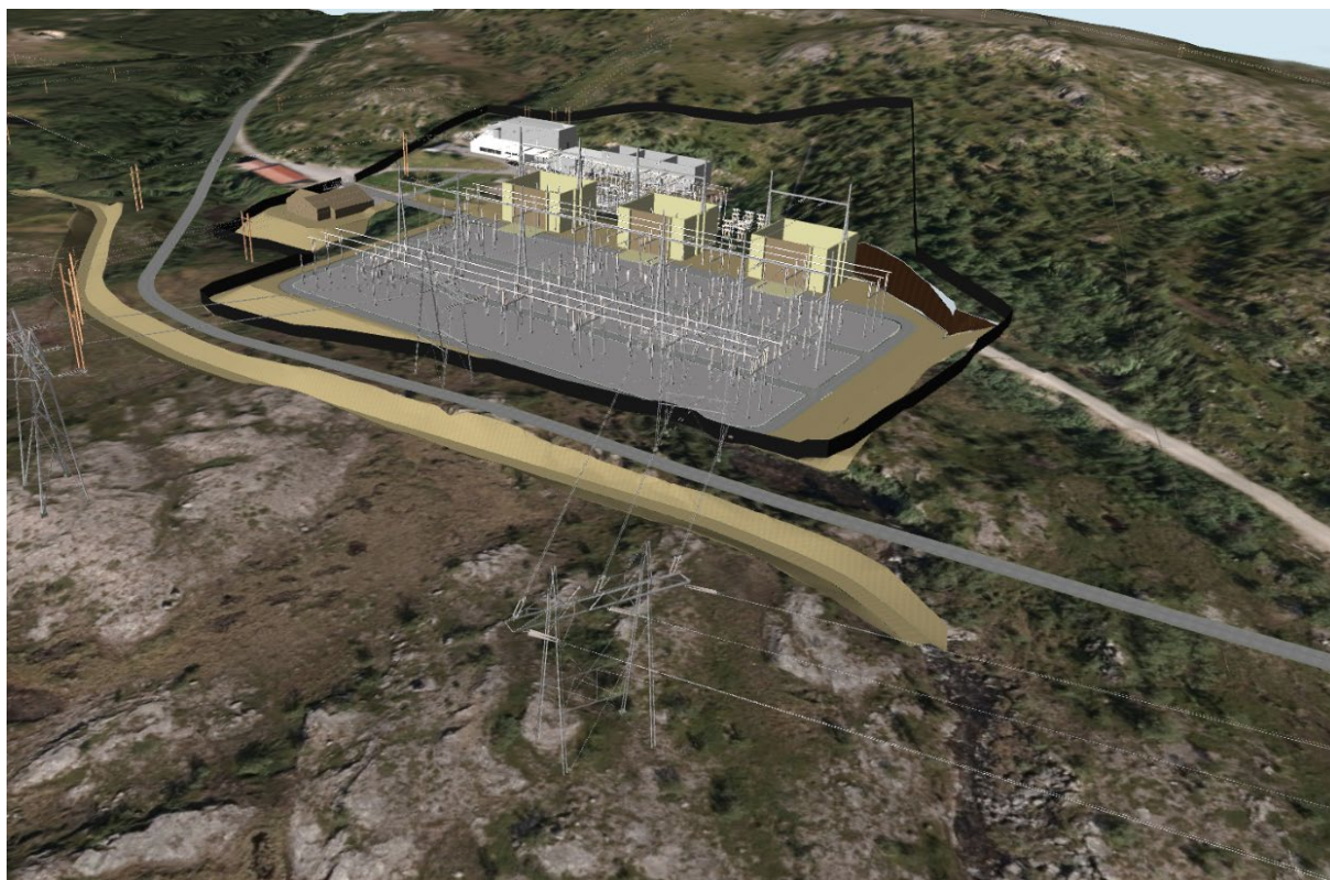
Figur 45: Eksempel på utforming av 420 kV anlegg i Lakselv transformatorstasjon. 3D modell som viser en utvidelse av Lakselv transformatorstasjon mot sør.
