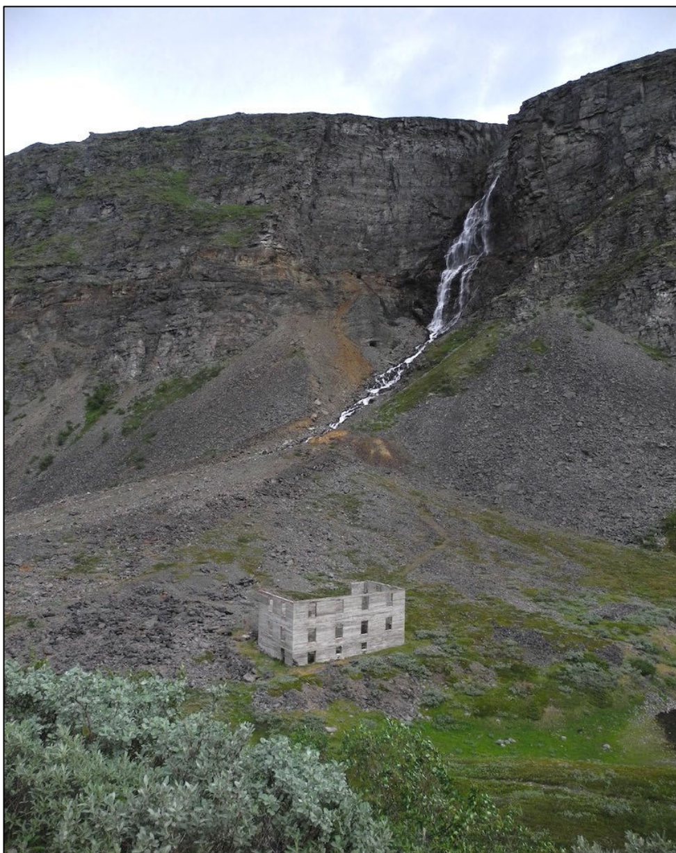
Figur 24 En bygning der veggene fortsatt delvis står, en rest av gruvedrifta som tidligere var rundt Ankerlia. Bygningen står nå som et nesten merkelig malplassert kulturminne ikke langt fra anleggsvei opp på snaufjellet. I bakgrunnen Sabasjohka, et mindre sidevassdrag som kommer ned fra Biertavárri og de gulbrune løsmassene der vitner også om gruvedrifta. Foto: Hallvard Skrede
