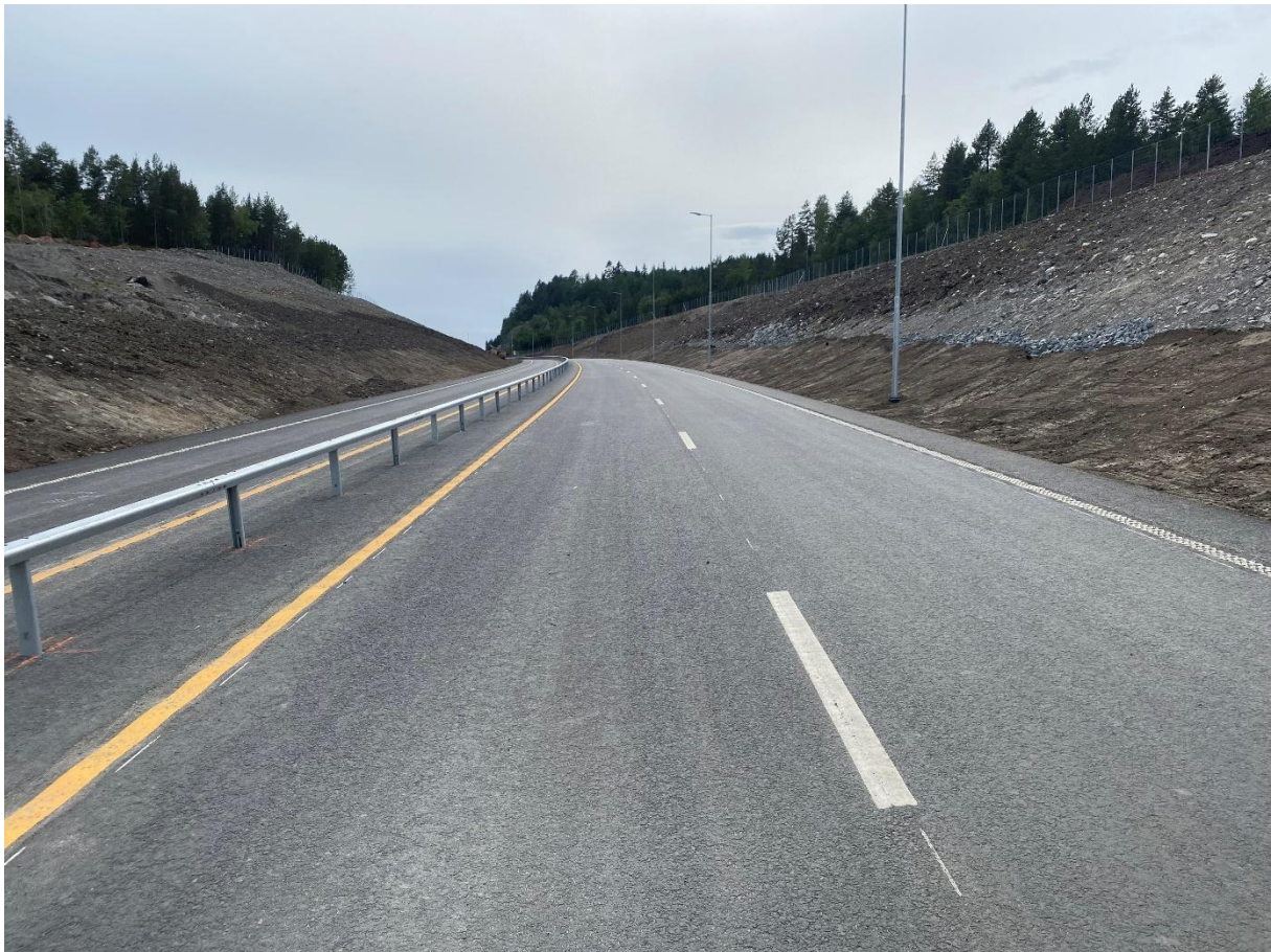
Vegkant ny veg E39 Lønset - Hjelset
