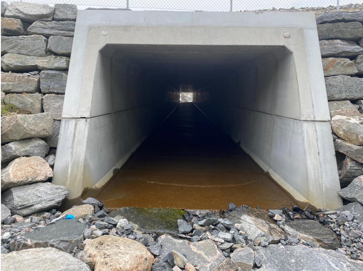
Kulvert Lønsetelva 22 juni 2024
