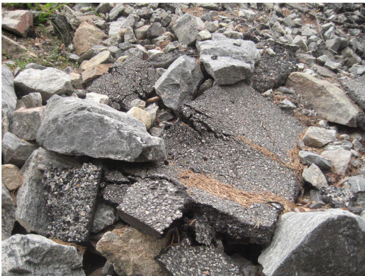
I 2018 lå det asfalt ved en av fyllingskantene
