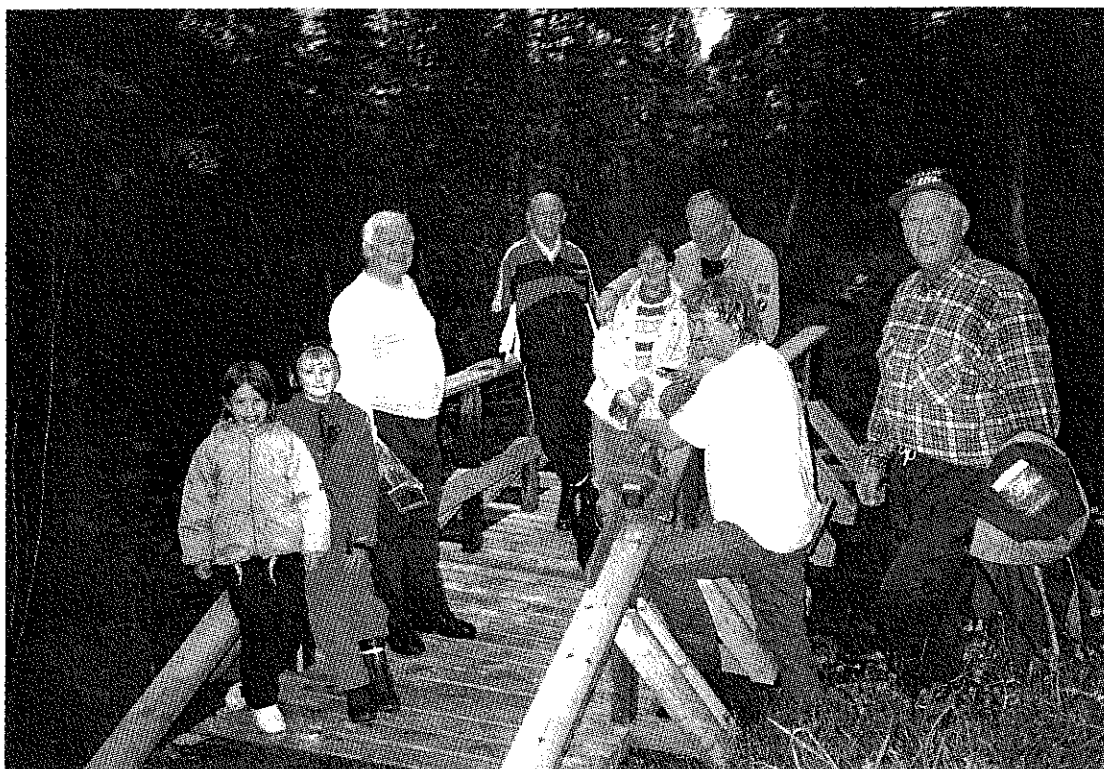
To nye gangbruer ble bygd ved Fjellbrudammen på dugnad av medlemmer i Moldemarkas venner og andre interesserte.
