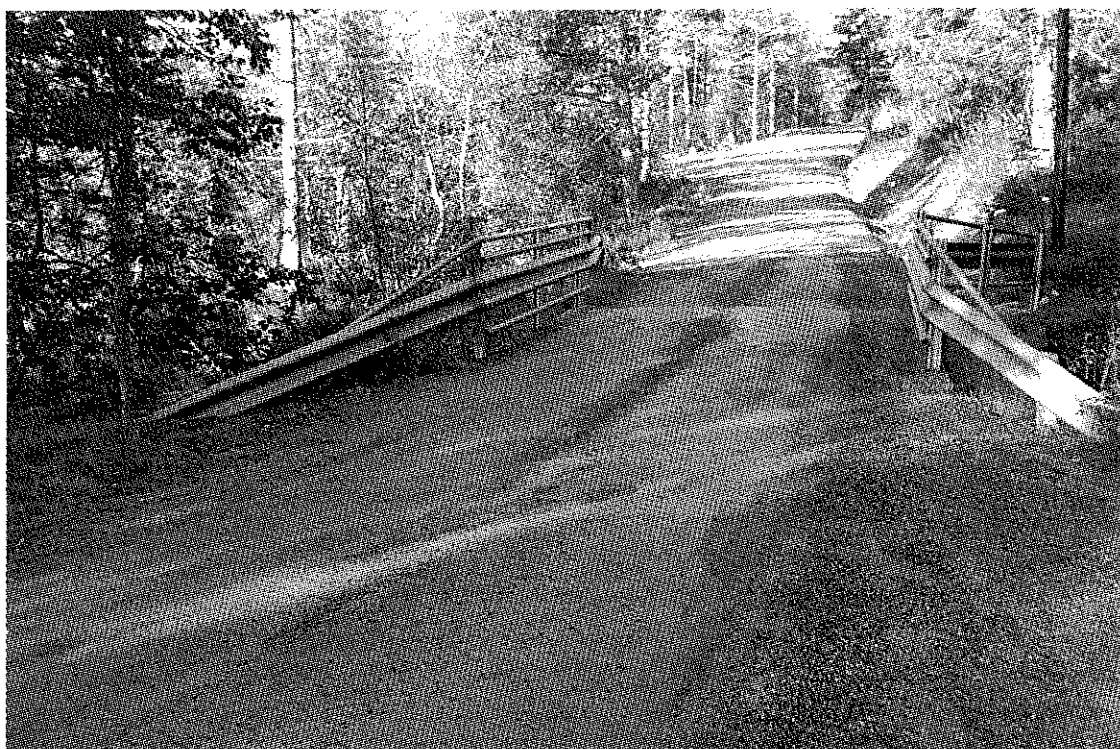
Ikke alle synes den estetiske standarden på denne brua fra 1994 er tilfredsstillende. Vardevegen.
