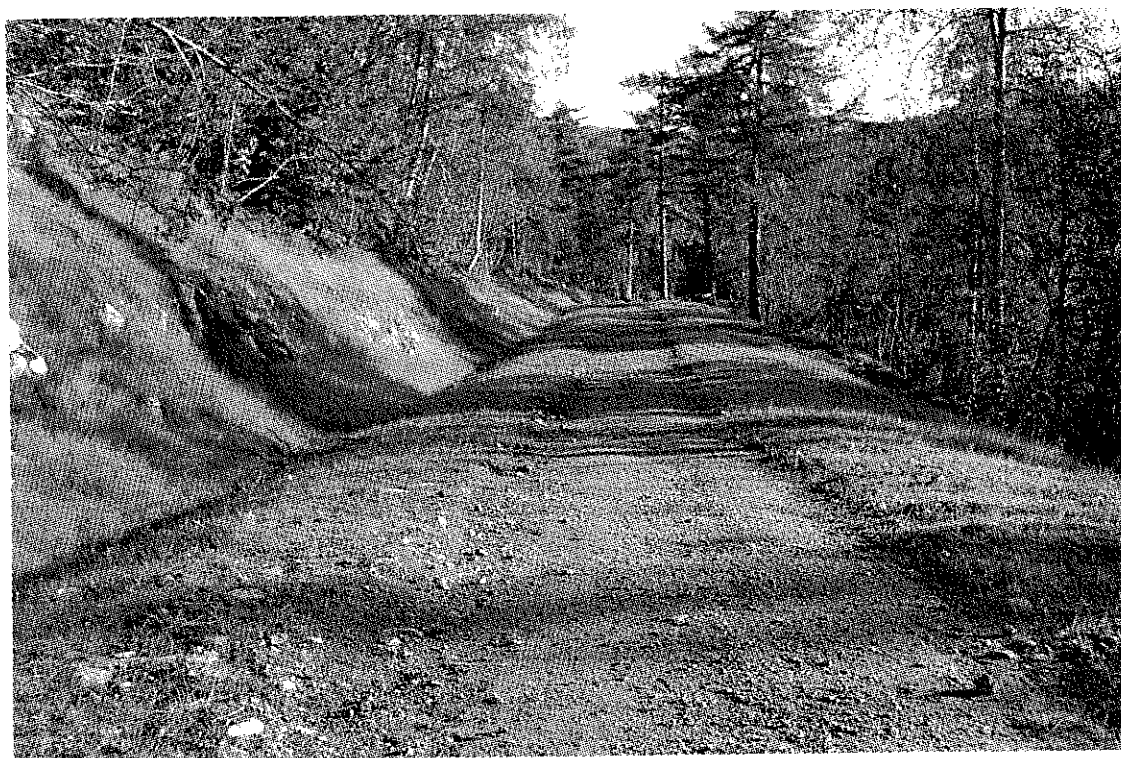
Ny turveg oppå vannledning mellom Fjellbrua og Nonsmyra.
