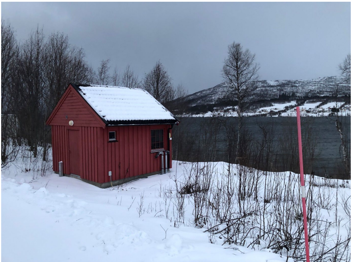
Bilde 2. Renseanlegg på Reinelv. Teknisk etat i Sørreisa kommune er etter vår erfaring ukentlig og ser til renseanlegget. Dette er en kostbar infrastruktur som i tillegg også krever for eksempel veier og brøyting. Slike anlegg finnes i ulike størrelser rundt hele Rossfjordvassdraget. (Foto: Roar Jørgensen).
