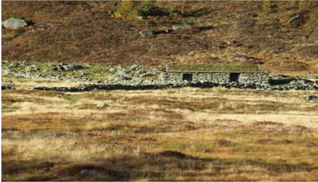
Det gamle steinhuset på Austdalstølen.
